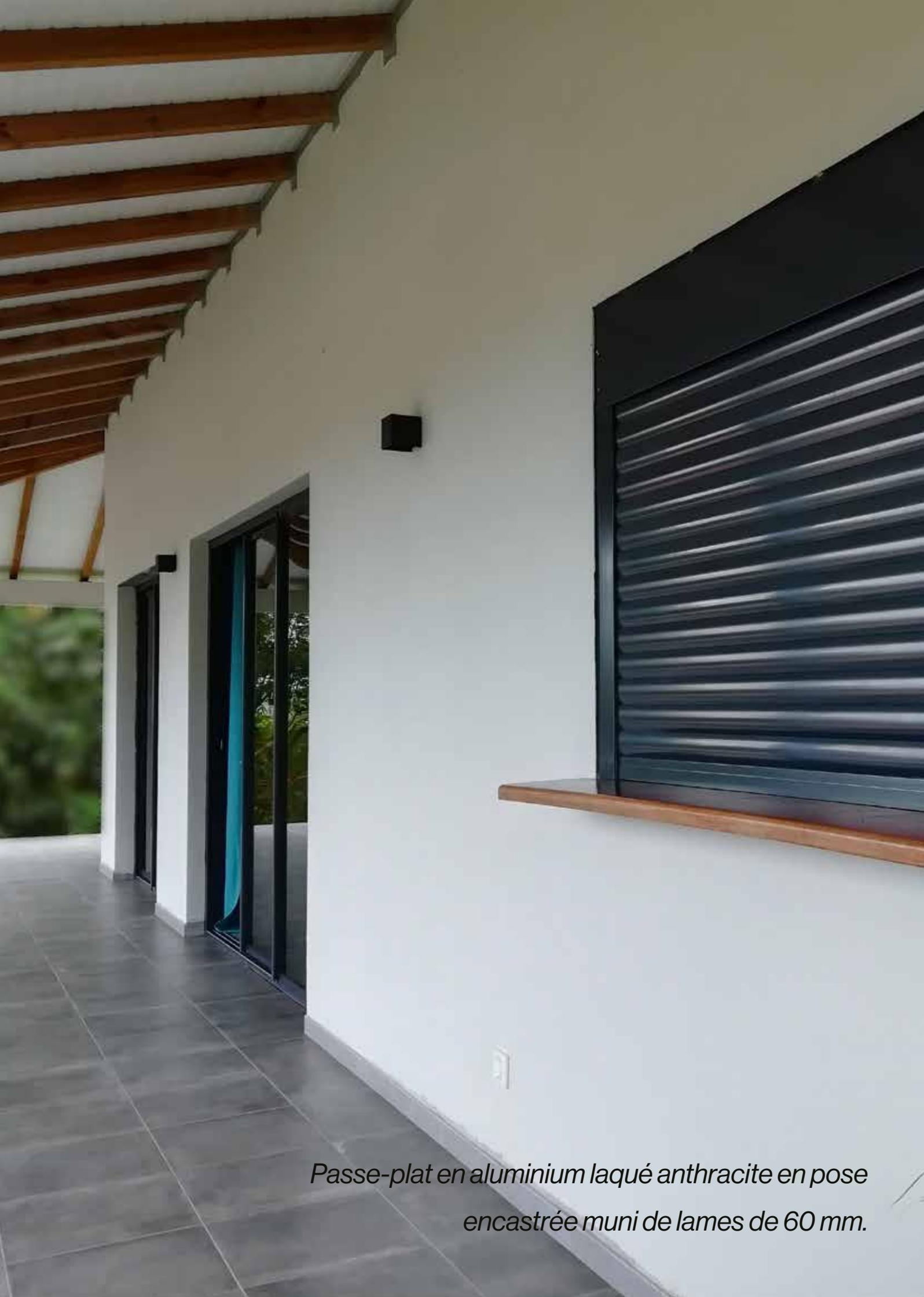
*Passe-plat en aluminium laqué anthracite en pose encastrée muni de lames de 60 mm.*
